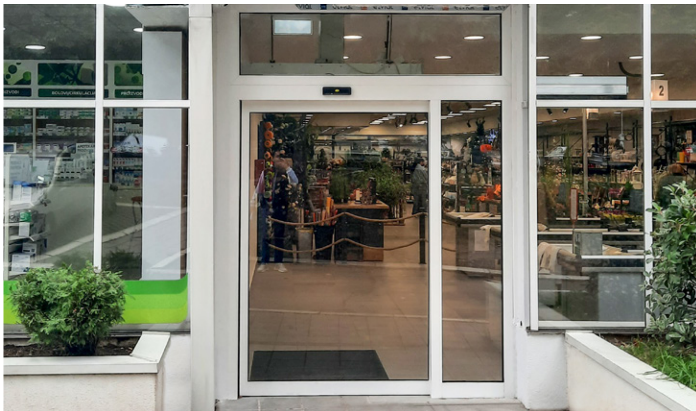
slika 1. Jednokrilna automatska klizna vrata sa fiksiranim krilom
