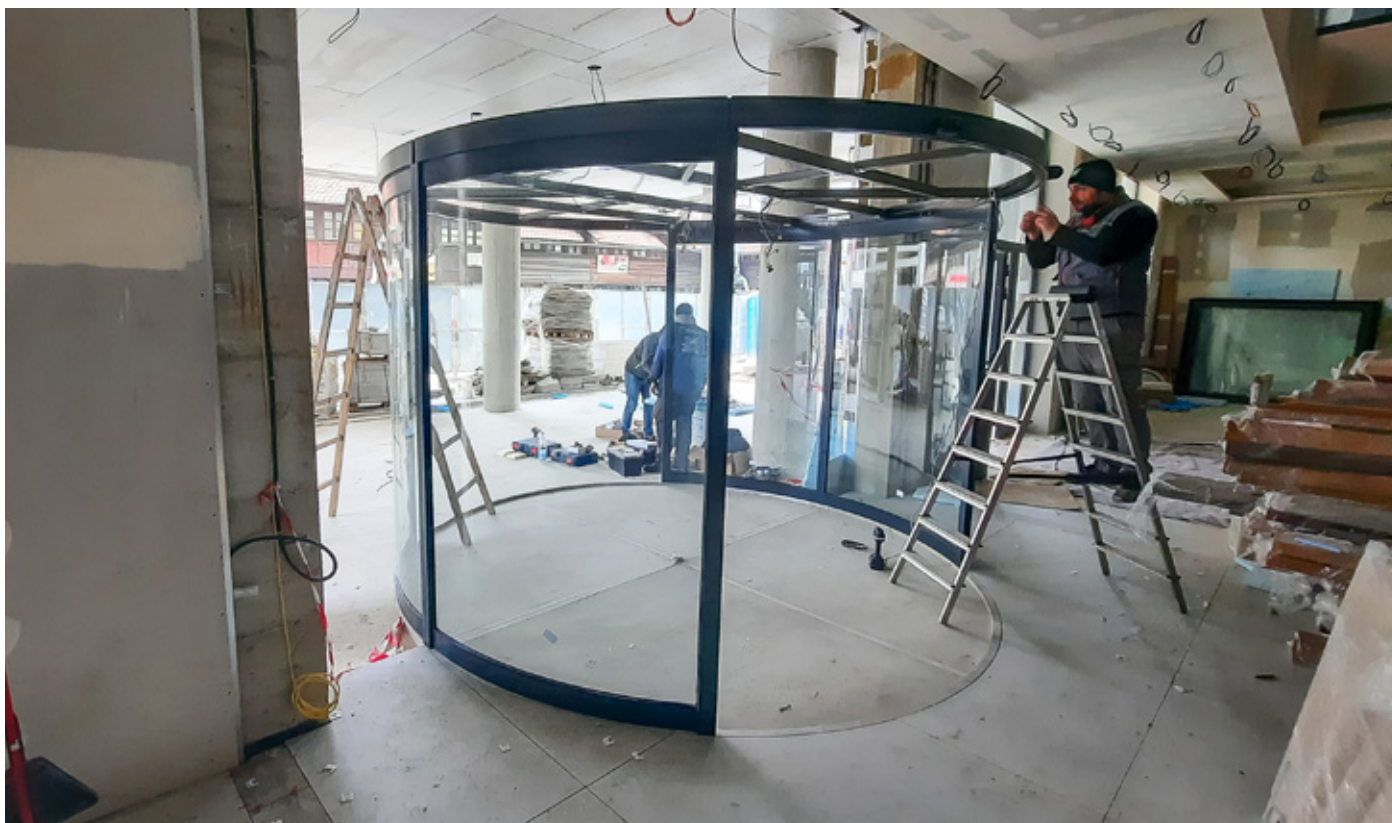
slika 3. Rotaciona (karusel) automatska vrata
