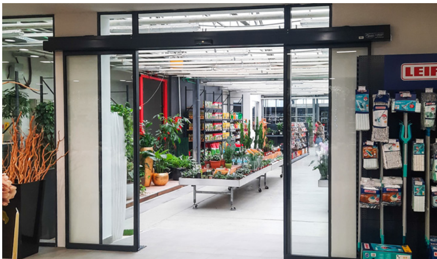
slika 2. Dvokrilna automatska klizna vrata sa fiksiranim krilima
